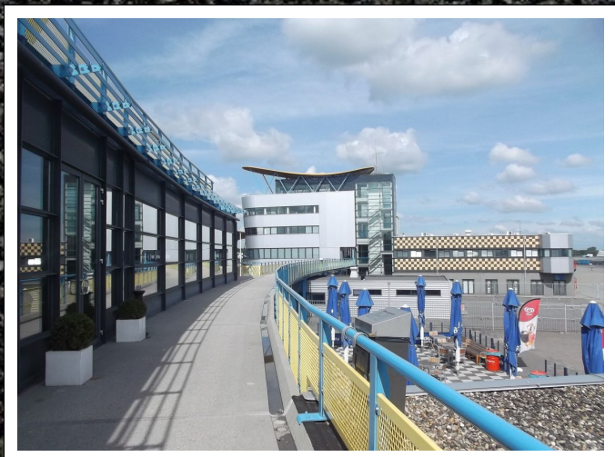
La passerelle qui mène à la tour de contrôle
